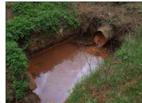
Obr. č. 30: Spodná výusť drenážnej vody z odkaliska
