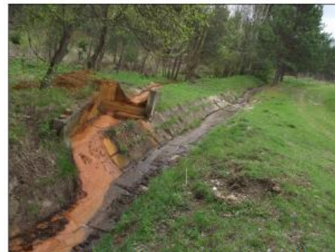
Obr. č. 29: Vrchná výusť drenážnej vody z odkaliska
