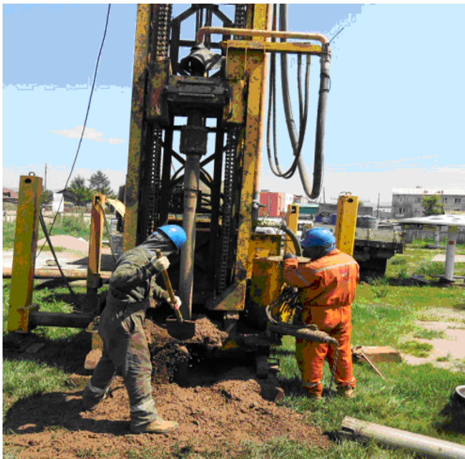
Bulgan - vrtání hydrogeologického vrtu
