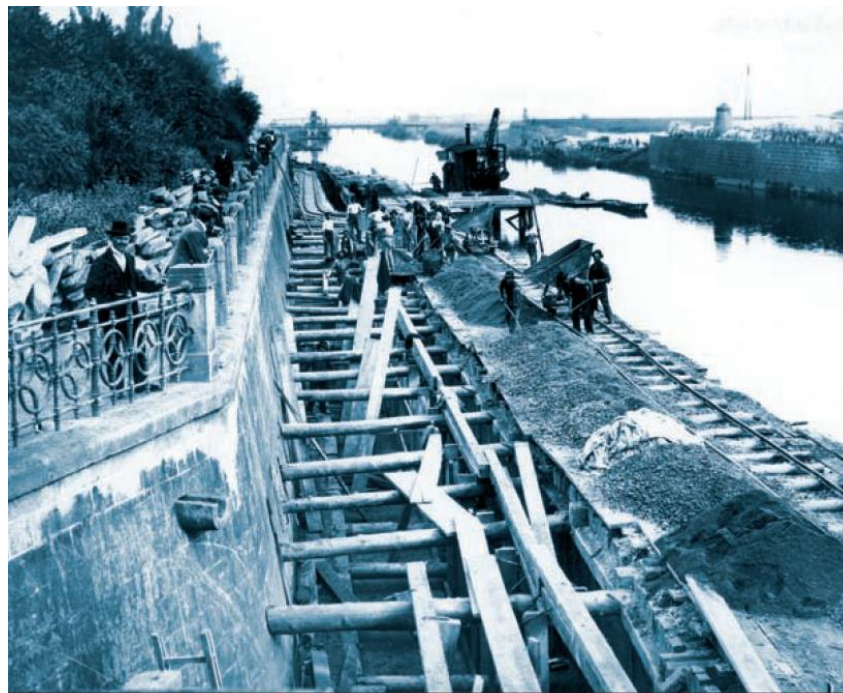
Zajišťovací práce levé nábrežní zdi nad Pražským pevnostním mostem (1908)
