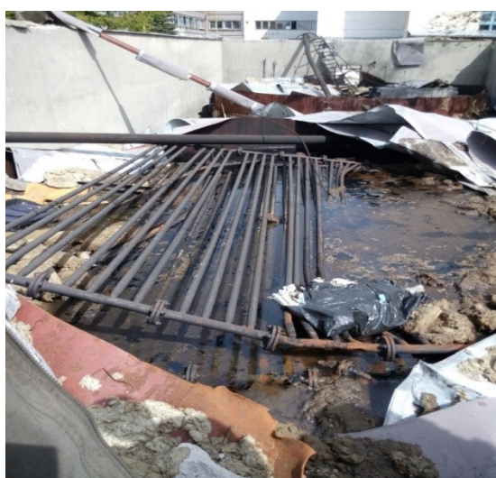
Obr. 9: Bývalé nádrže na mazut
