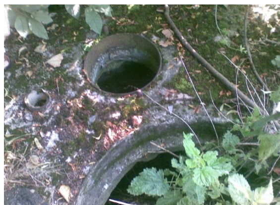
Obr. 4: Šachta k podzemnej nádrži
