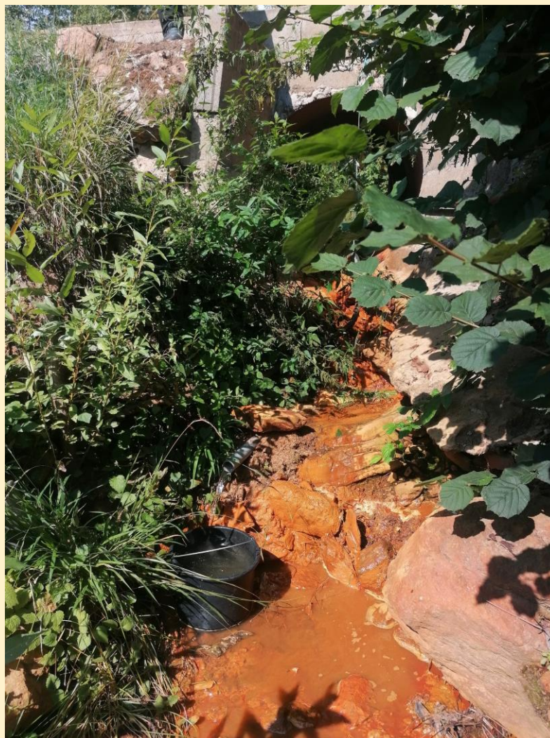
PD423-4 výtok z podzemného potrubia drenáže
